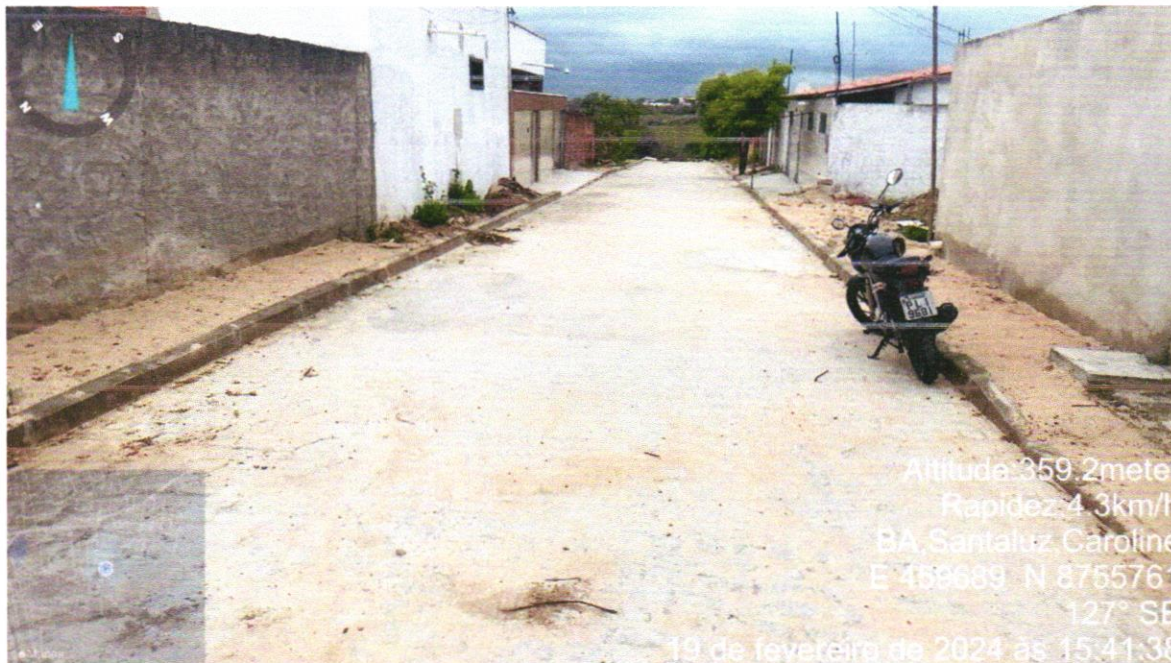
Execução de pavimentação na Trav João Muniz Barreto
