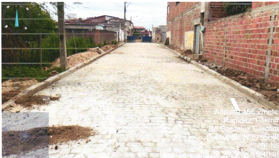
Execução de pavimentação na rua 2ª Trav João Muniz Barreto
