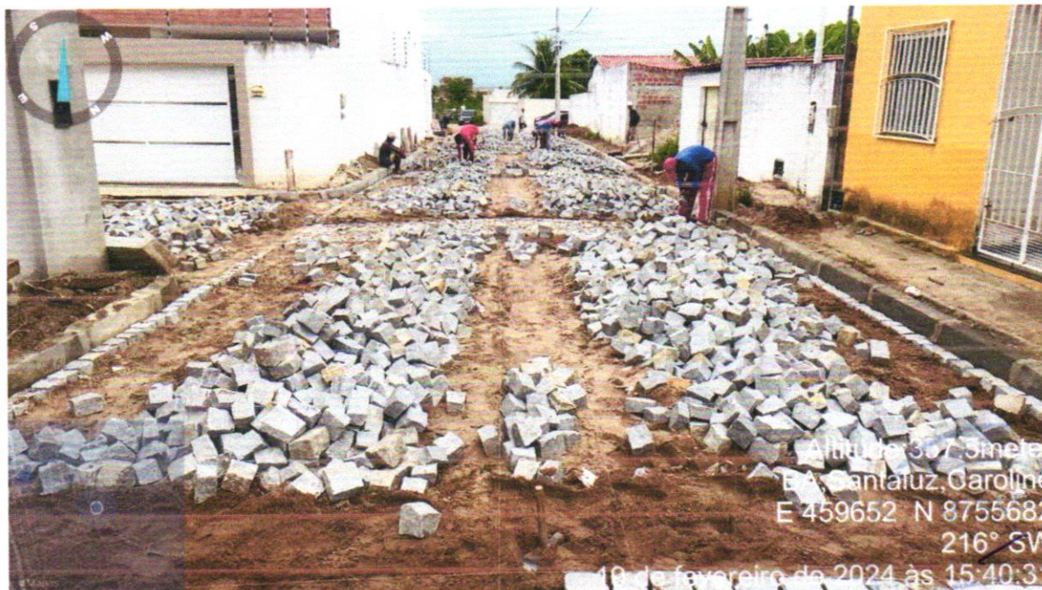
Execução de pavimentação na 2ª Trav João Muniz Barreto
