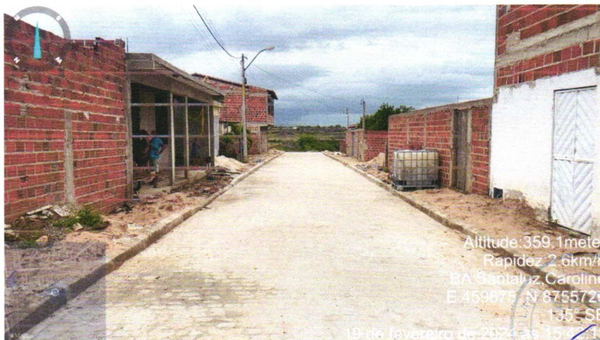
Execução de pavimentação na 1ª Trav João Muniz Barreto
